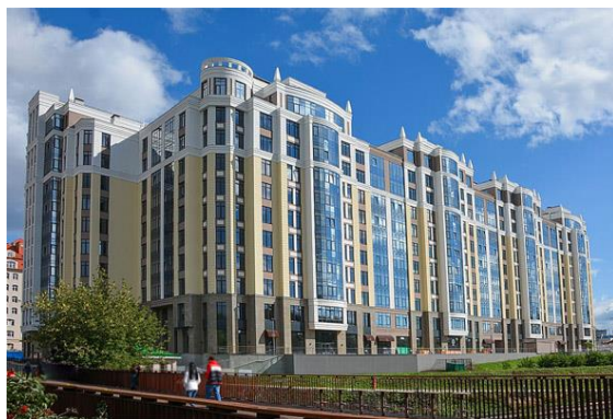
Клубный дом «Ривьера» г. Екатеринбург, ул. Горького, д. 36
